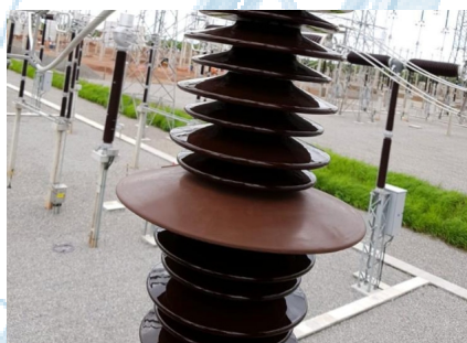
BOOSTER SHED HTV INSTALADO EM SE 500 kV Booster Shed HTV instalado en subestación 500 kV
