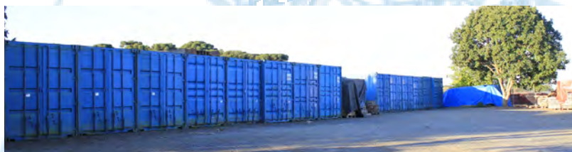
ESTOQUE DE ISOLADORES DE PORCELANA DE 230 A 500 kV Stock de aisladores de Porcelana desde 230 hasta 500 kV
