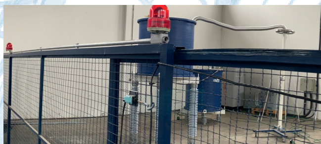
LABORATÓRIO DE TENSÃO APLICADA Laboratorio de Tensión Aplicada
